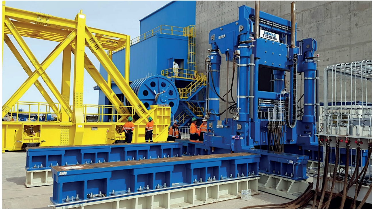
挂绳准备：设备的装配和功能测试。右图为带液压系统的6绳钢丝绳夹紧提升装置。
