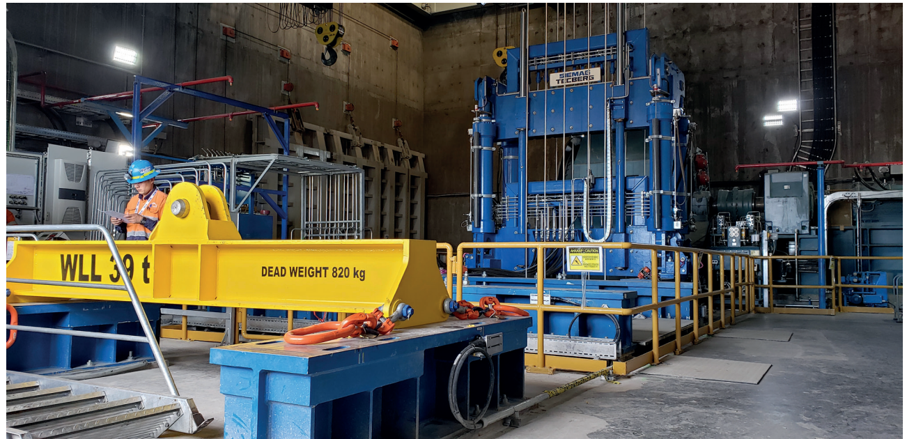
Einrichtung der 6-Seil Hub- und Klemmvorrichtung im Schacht 2 von Oyu Tolgoi.
