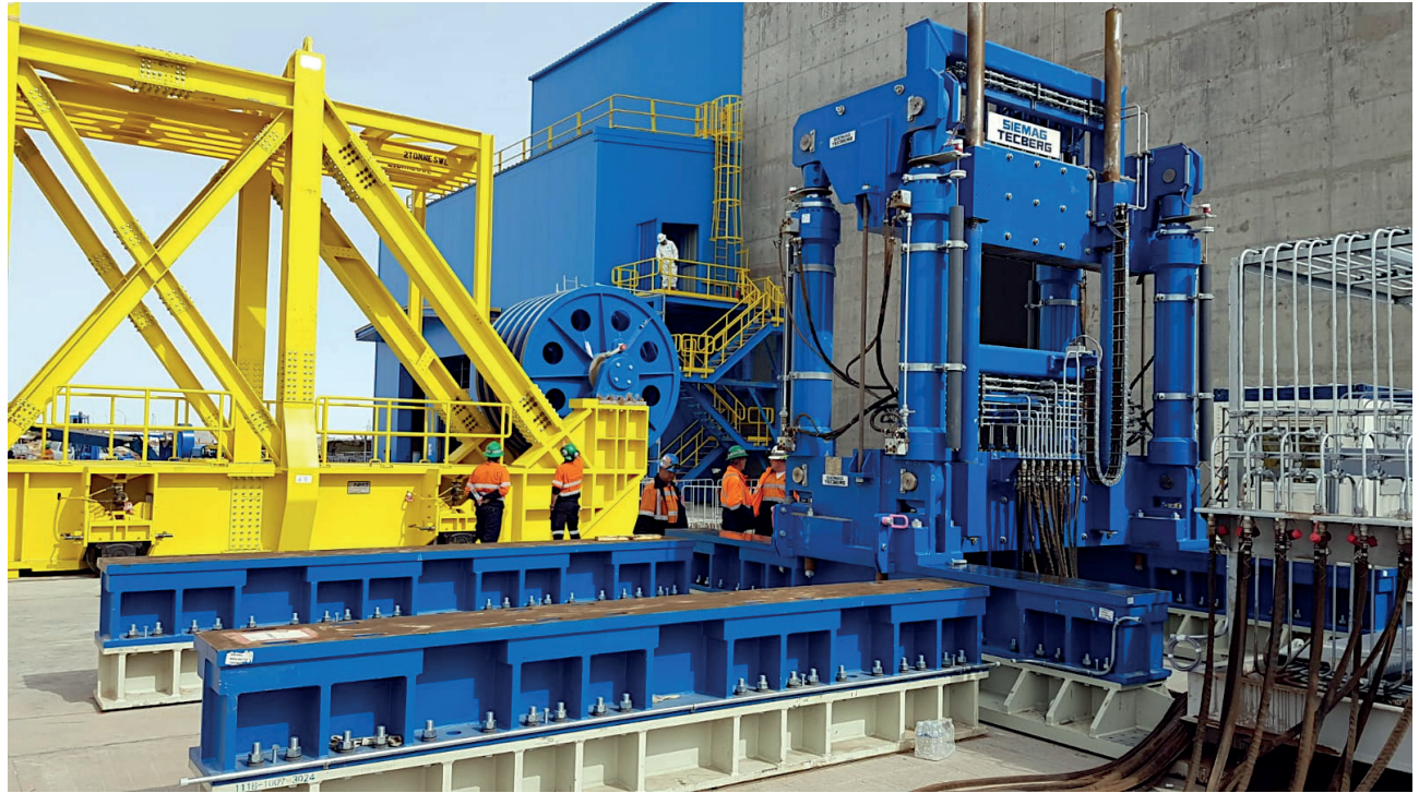
Vorbereitungen für das Seilaulagen: Aufbau und Funktionstests des Equipments. Rechts im Bild die 6-Seil Klemm- und Hubvorrichtung mit Hydraulikanlage.
