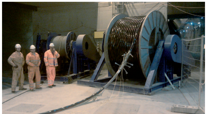
Bild 9: Aufstellung der beiden Wickelhaspel zur Kabelmontage am Schachtfuß
