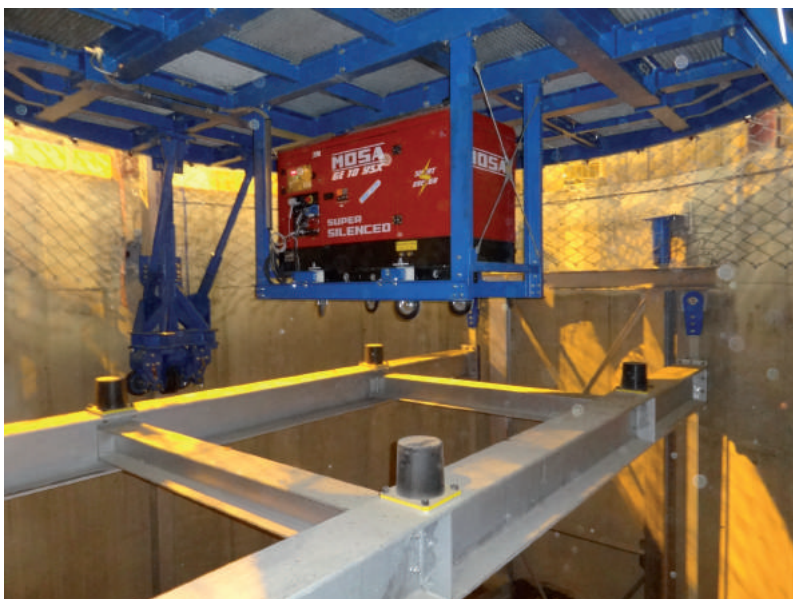
Bild 14: Übertreibabbremseinrichtungen Siemag Tecberg Safety Arrestor (SSA) im Schachtfuß
