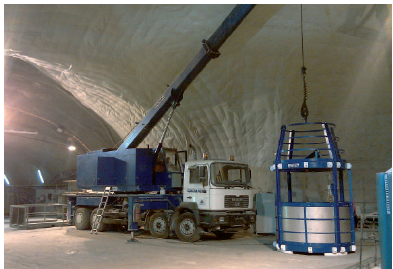
Bild 6: Mobile Schachtwinde mit angeschlagenem Inspektionskorb am Schacht II
