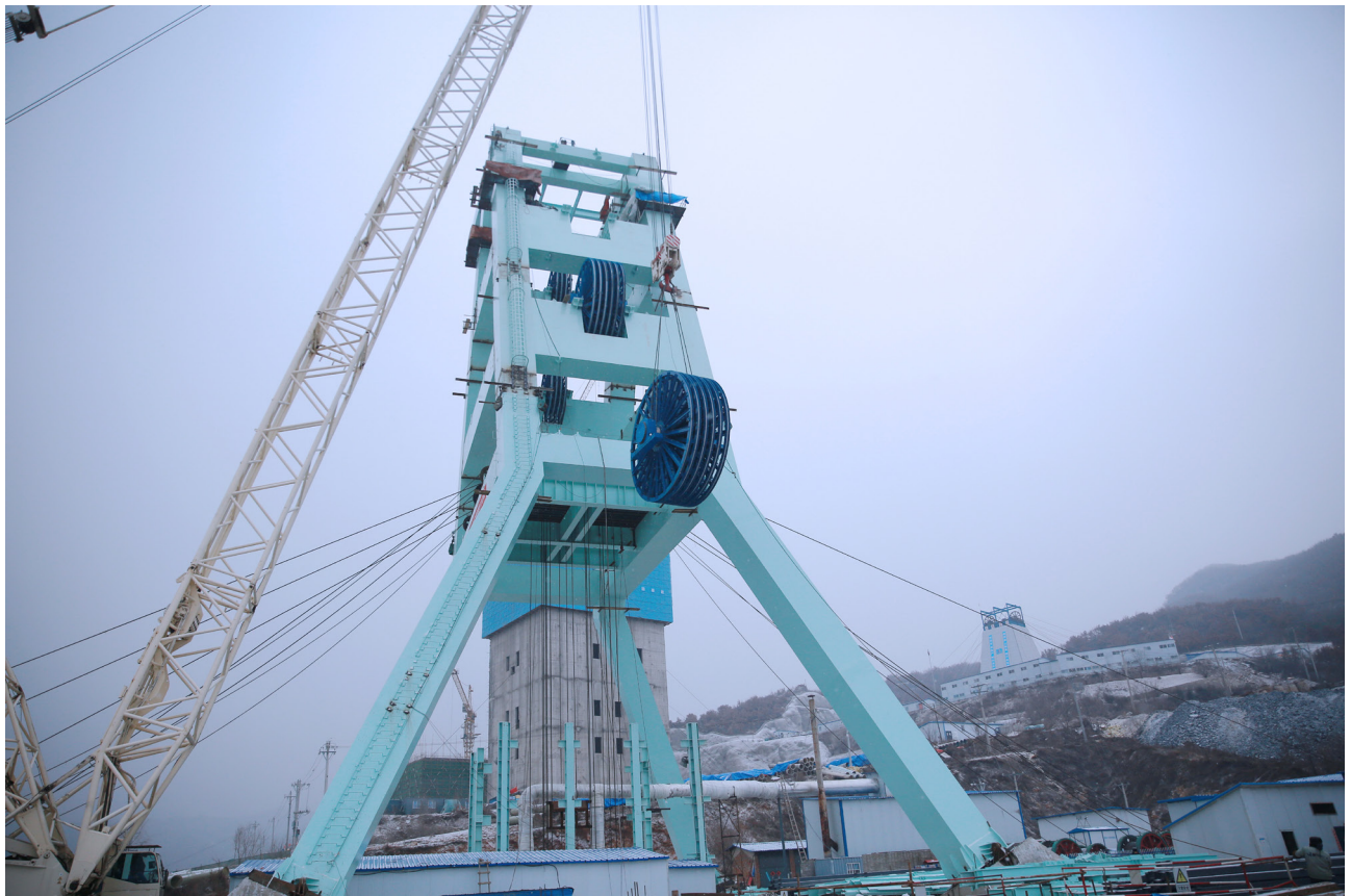
图1：开始在思山岭矿现场安装提升机绳轮。版权所有2022天津西马格特宝有限公司。
