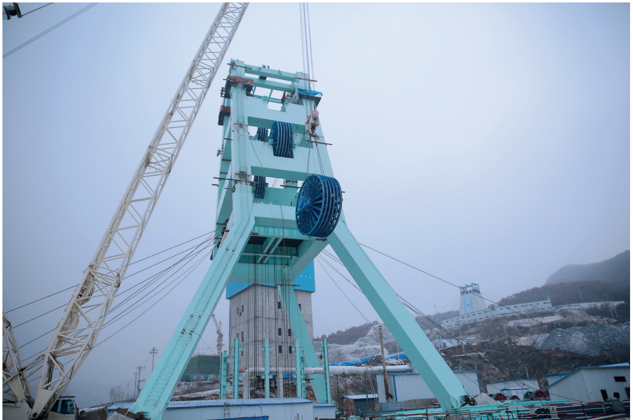
Abb. 1: Start der Installationen vor Ort mit dem Einbau von Seilscheiben in das Fördergerüst des Bergwerks Sishanling. Copyright 2022 Tianjin SIEMAG TECBERG.
