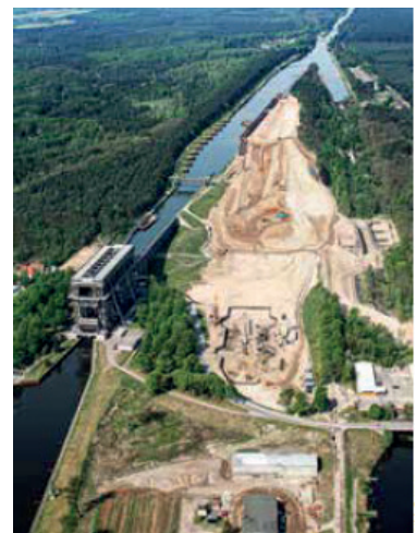
Разработка котлована рядом с историческим подъёмником (© WNA)
