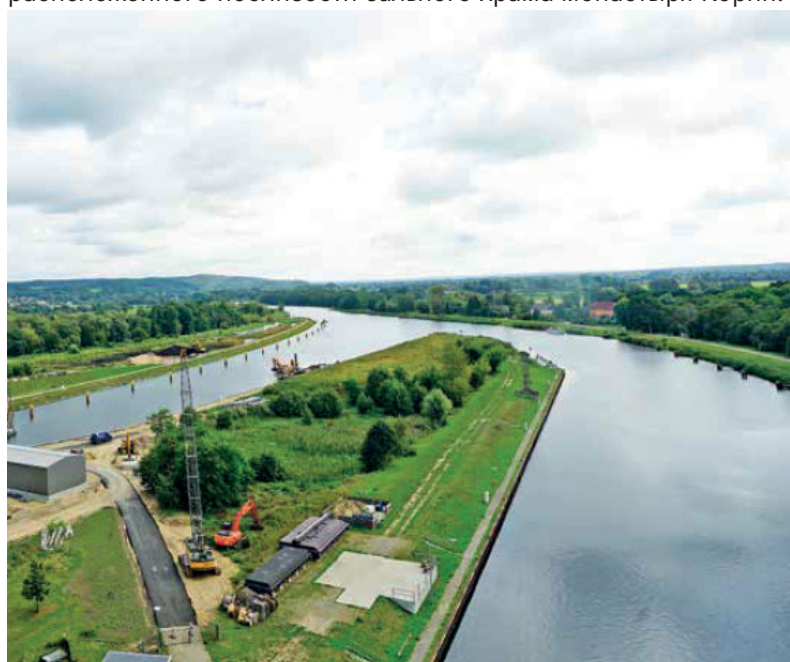
Последние наружные работы вокруг нового сооружения (© Александр Рехенбах)
