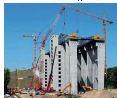
Установка элемента отделения канатных шкивов (© WNA)
