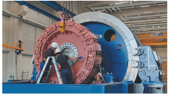
Монтаж подъёмной машины системы Кёпе на испытательном стенде в TECBERG парке – посадка ротора приводного двигателя на вал
